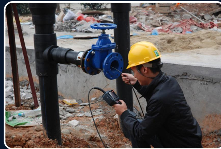
工业管道检测现场作业实景
